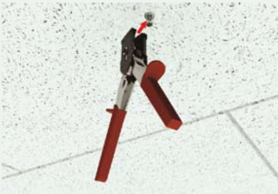
3: Grib fat om skruen med monteringsstangen.
