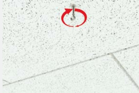
6: Skru ophængskrogen fast i pluggen.
