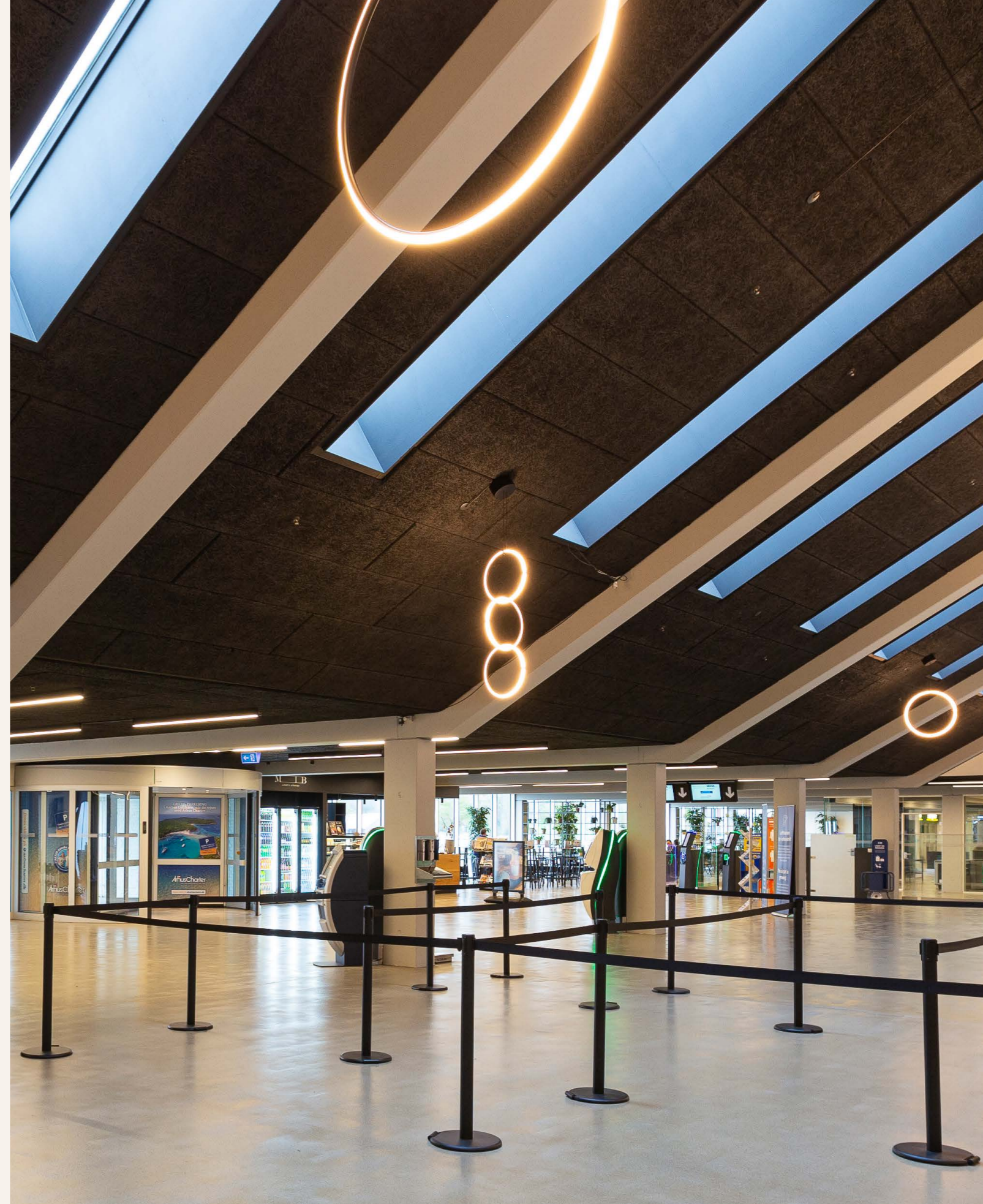
Troldekt akustikplader kan males flere gange, uden det forringer pladernes egenskaber. Aarhus Lufthavn har valgt at forlænge Troldekt lofternes levetid ved at male dem sorte under renoveringen.
