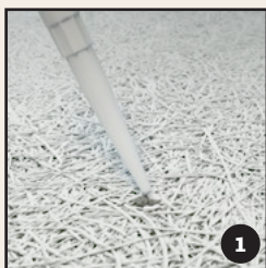
Påfør fugemasse
